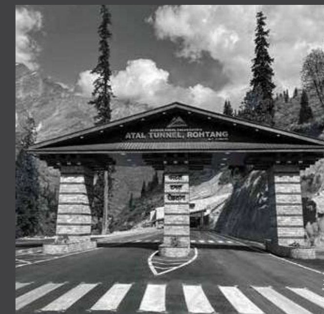
ATAL TUNNEL, ROHTANG
